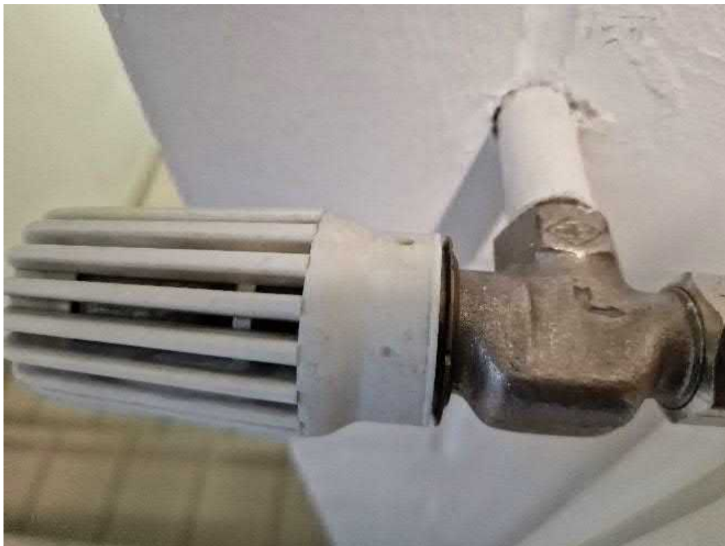
Abbildung 13 Heizungsregler
