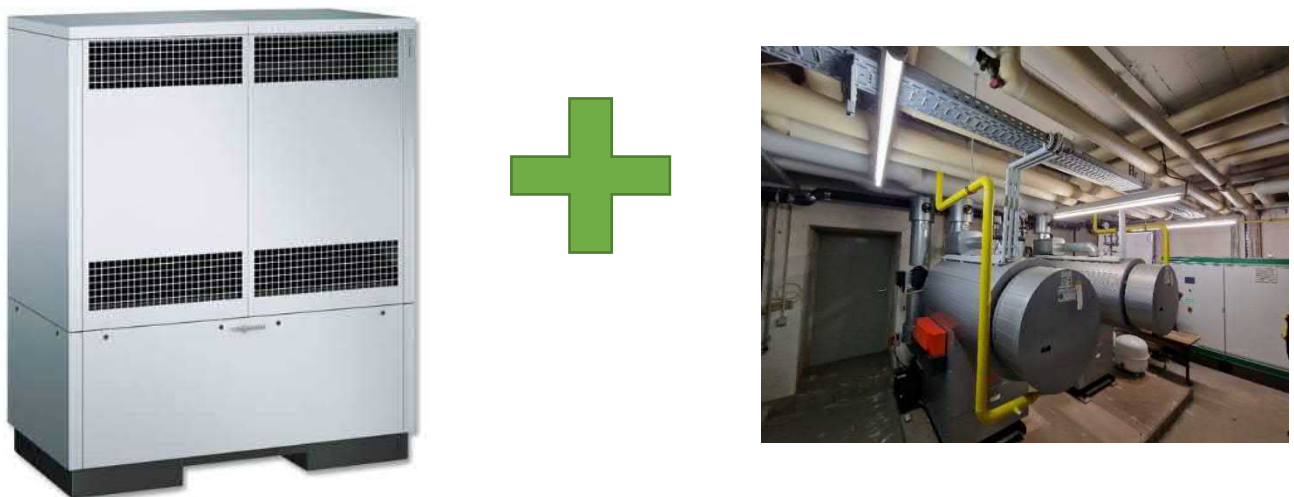
Abbildung 43 Beispiel einer Hybridanlage
